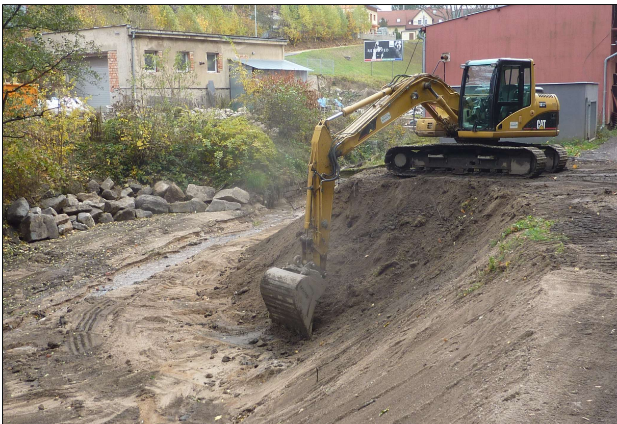
Obr. 10: Nátoková část nádrže – během těžení, místo sjezdu (2015)
